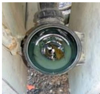
Εικόνα 57: Φίλτρο με ακαθαρσίες (Φύλλα)
