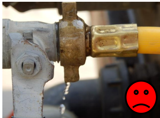
Εικόνα 31: Στατική διαρροή από σωλήνωση
